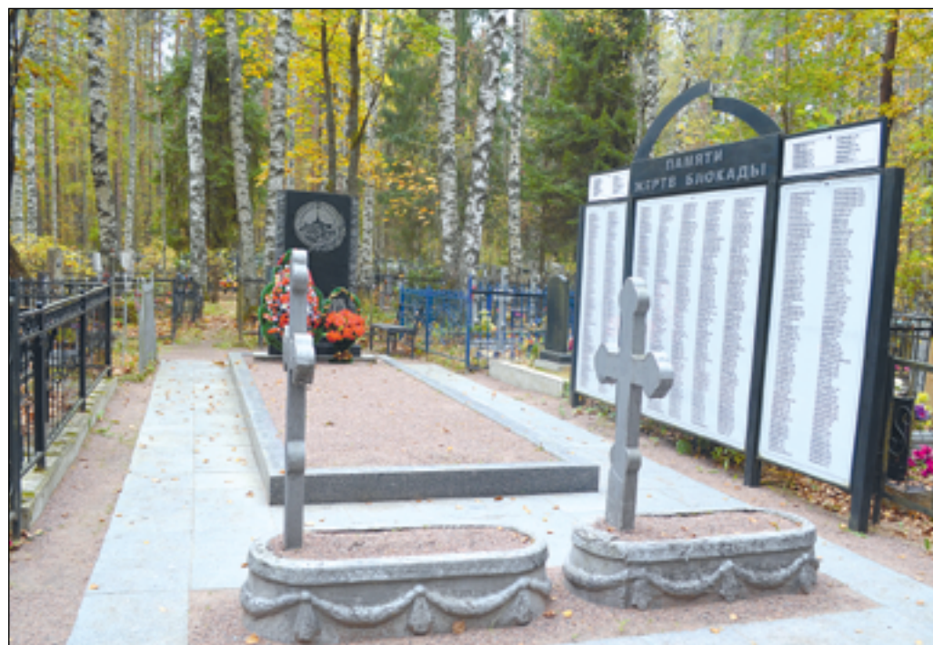
Силами ООО «Собор» была проведена работа по реставрации мемориала жертвам блокады и благоустройству территории. Здесь был заменен бетонный поребрик на гранитный, дорожки вокруг захоронения вымощены гранитными плитами
