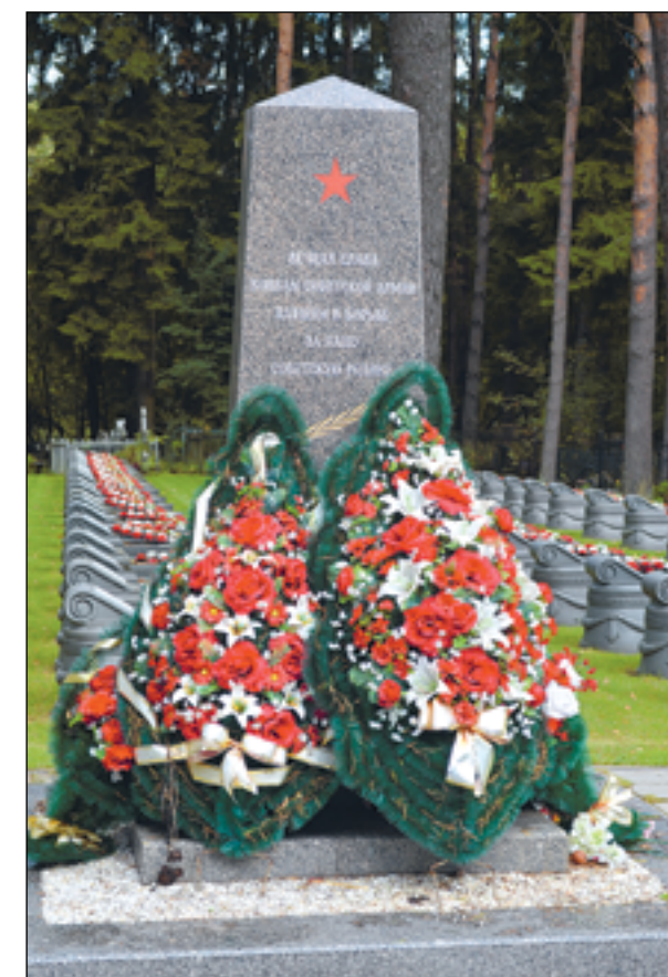
Работа по реставрации воинского мемориала, установленного на территории Песочинского кладбища в 1967 году, и благоустройству прилегающей территории была выполнена ООО «Собор». Под стелой бетонный поребрик был заменен на гранитный, стела отполирована, на ней обновлена надпись
