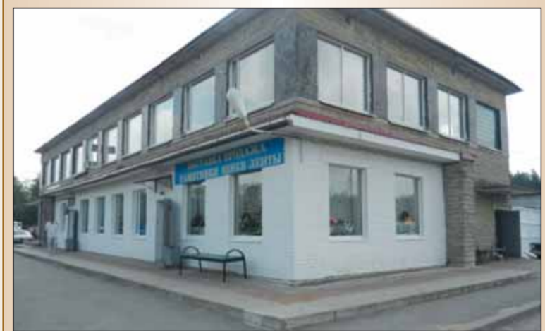
Здание администрации кладбища
