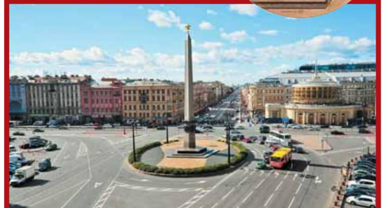
Пятигранный монумент состоит из венчающего навершия, центрального ствола высотой 22,5 метра, десятиметровой базы и основания. Общая высота обелиска — 36 метров. Диаметр базы — 3,6 метра. Ширина основания — 9 метров. Вес основной части — 360 тонн. Общий вес монумента с базой и основанием — 750 тонн. Диаметр бронзового венка — 4,5 метра. Высота навершия вместе со звездой — 3,6 метра. Диаметр «Золотой Звезды», выполненной из нержавеющей стали, — 1,8 метра.
