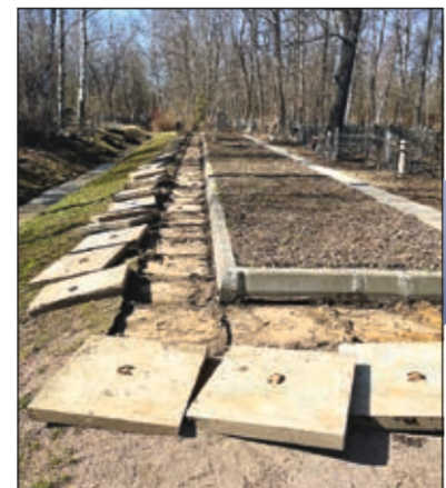
Замена плит у воинского братского захоронения
