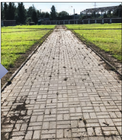
Работы по очистке плиточного мощения
