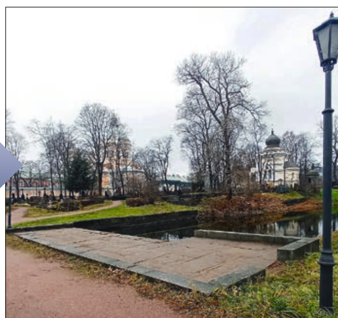
Капитальный ремонт смотровой площадки на берегу Монастырского пруда
