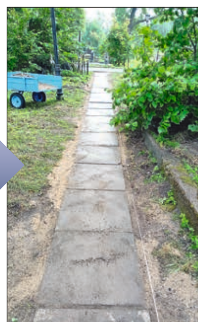
Мощение дорожки из бетонных плит
