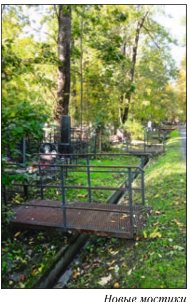
Новые мостики через дренажные канавы
