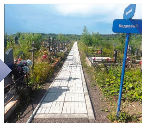
Мощение дорожки тротуарной плиткой
