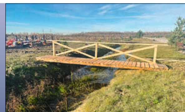
Установка пешеходных мостков через дренажные каналы
