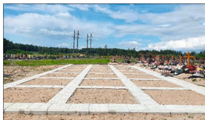
Подготовленный участок для захоронений
