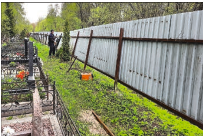
Зачистка от поврежденной краски и ржавчины, окраска и выравнивание оградений из металлопрофиля
