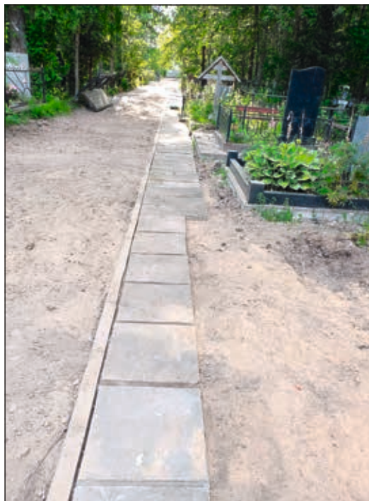
Ремонт плиточной дорожки
