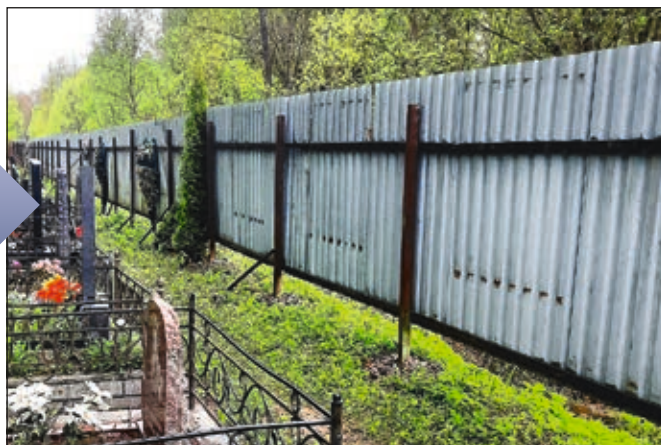
Зачистка от поврежденной краски и ржавчины, окраска и выравнивание оградений из металлопрофиля
