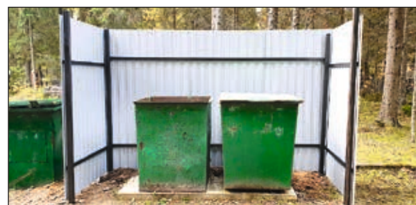
Монтаж контейнерной площадки
