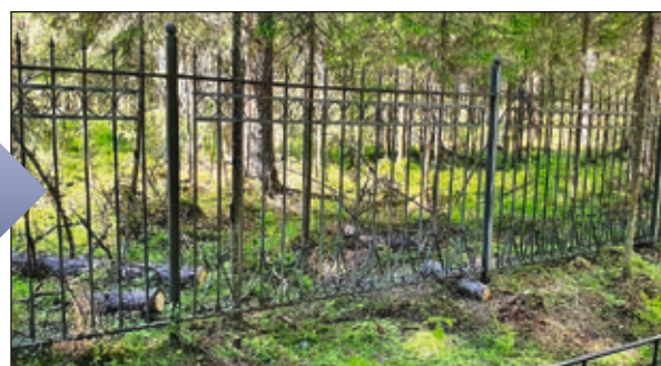
Ремонт ограждения после падения деревьев
