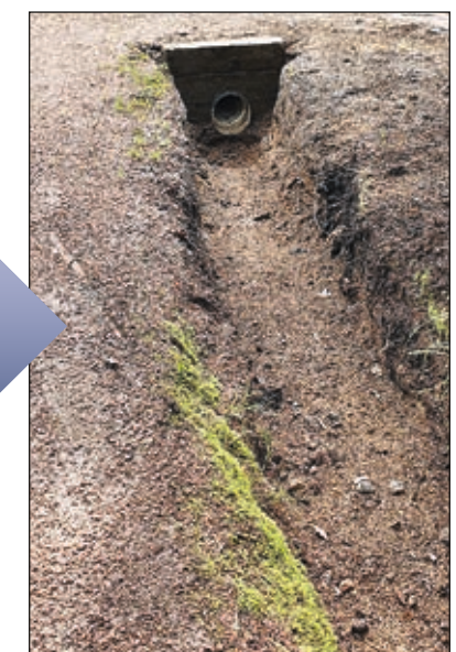
Обустройство дренажной системы
