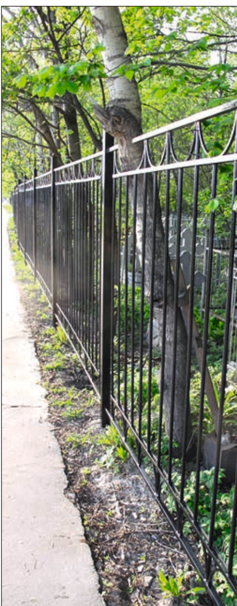
Покраска металлической ограды
