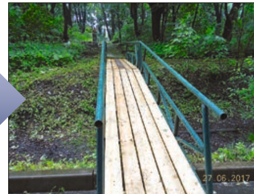
Установка новых мостков через дренажные канавы
