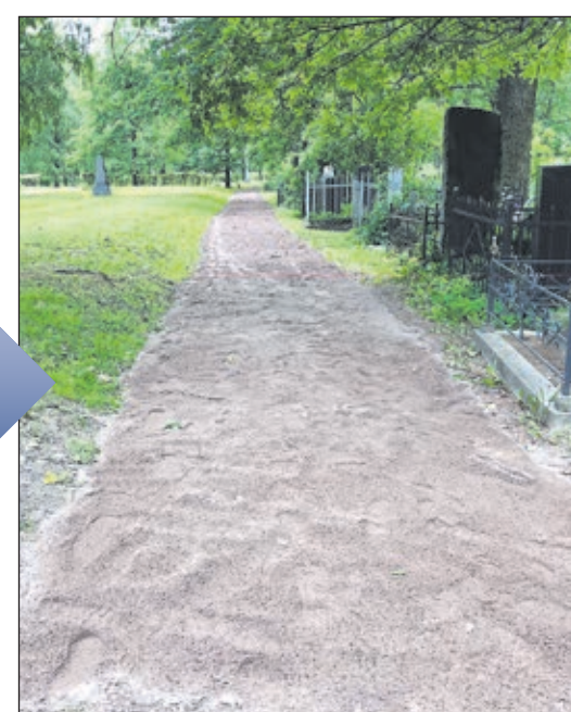
Обустройство набивных дорожек
