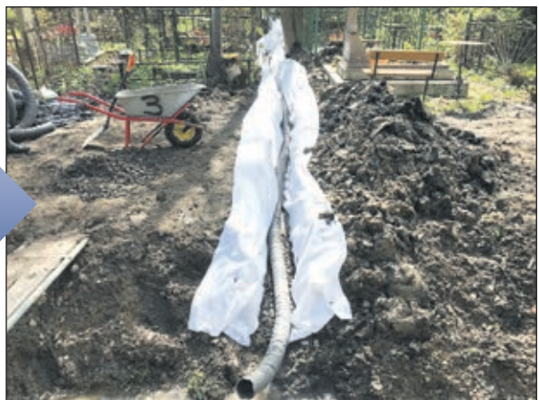
ООО «Ритуал» ведет работы по прокладке современных дренажных систем
