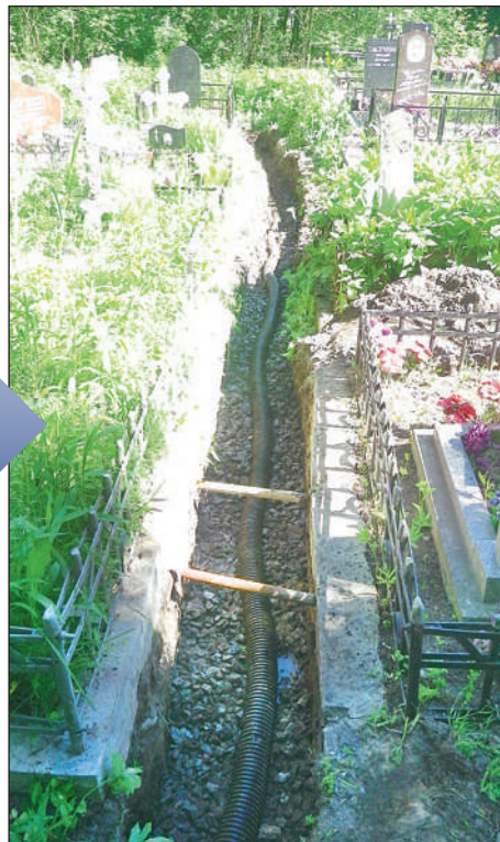
Работы по прокладке современной дренажной системы на Нижнем Красносельском кладбище
