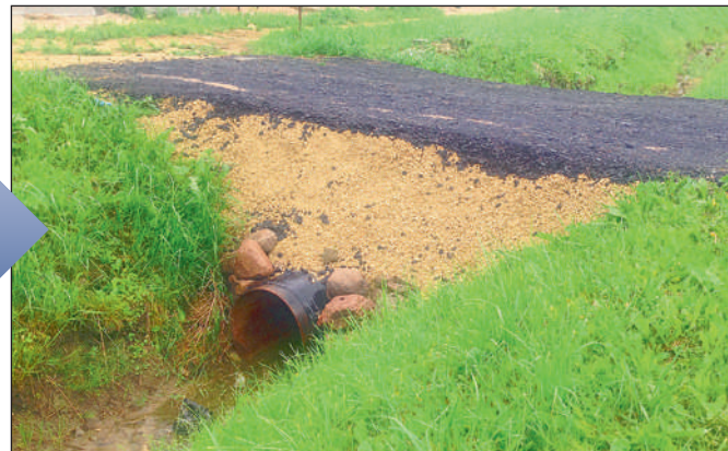
Ремонт трубопереезда на Павловском городском кладбище
