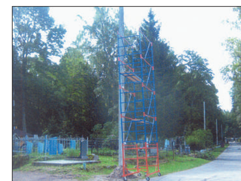
Установка осветительных столбов
