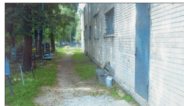
Ремонт дорожки перед административным зданием
