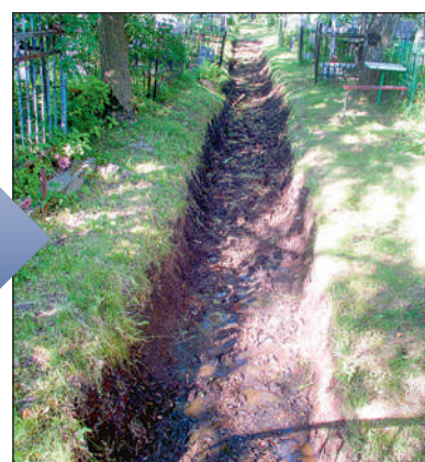
Профилирование канав
