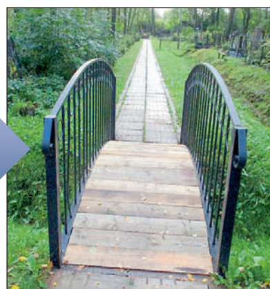
Ремонт мостиков через дренажные канавы
