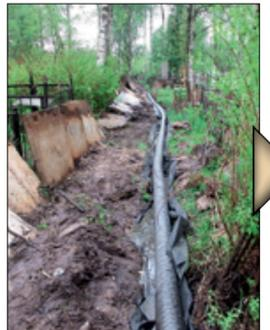
Ремонт засорившегося трубоперекрытия
