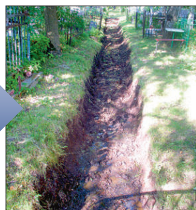
Профилирование канав
