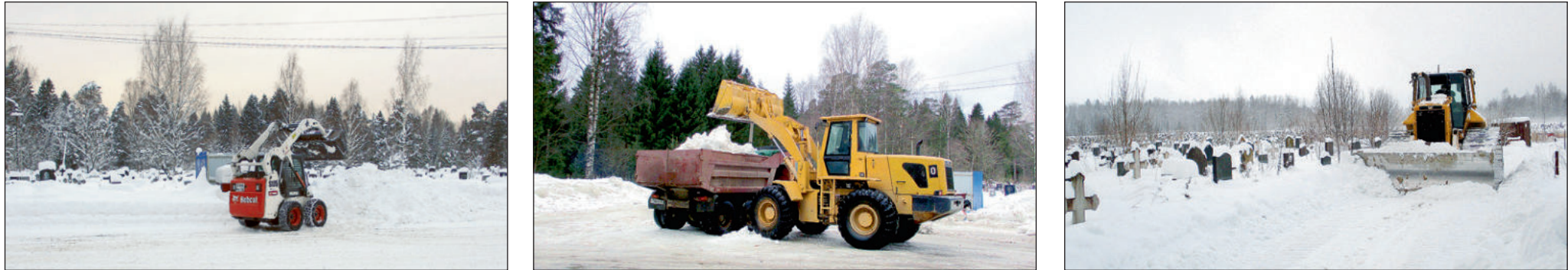
Крупнейшее в Санкт-Петербурге Северное кладбище. Ежедневные работы по очистке территории от снега осуществляет ООО «СИЭМ».
